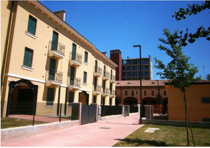
La facciata sud
